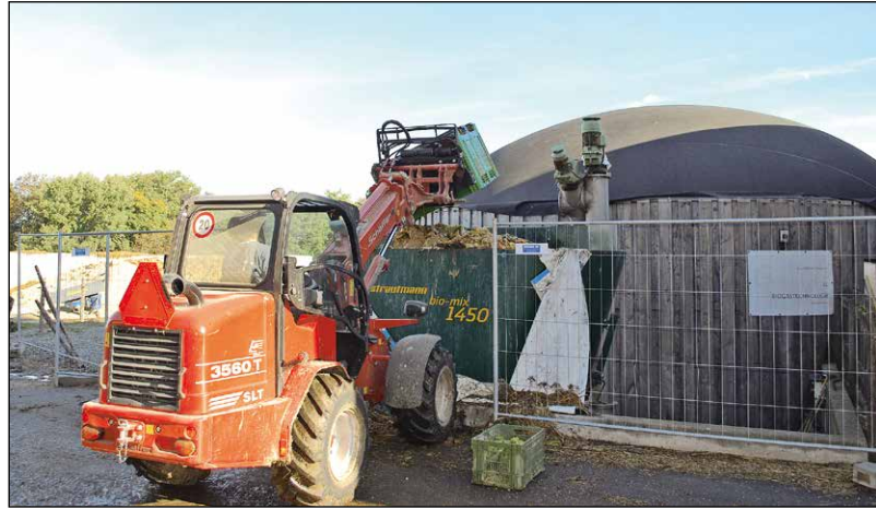
L'installation de biogaz
